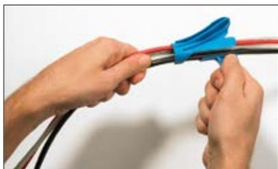
1) Junte todos os cabos e introduza-os na ferramenta de aplicação.
