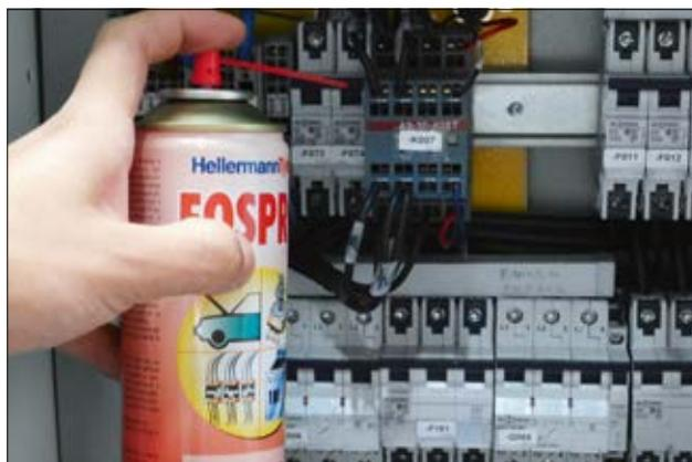
Fospro: fluido para limpeza de contatos elétricos.
