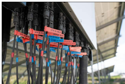
TAGPU - marcador de cabos especialmente desenvolvido para o setor de energia solar.
